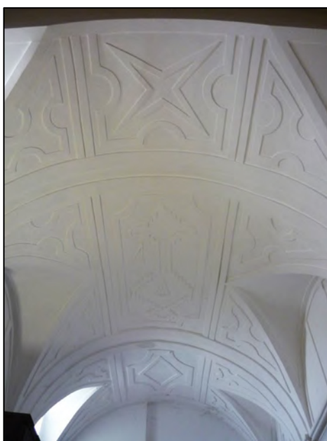
Fig. 14- Bóveda de la nave. Fotografía de la autora.
