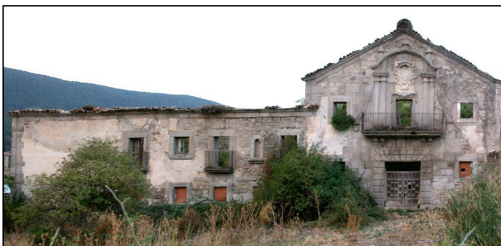
Fig. 11- Fachada principal del arruinado esquileo del marqués de Perales en El Espinar (Segovia), en la que se observa su gran portada labrada. Fotografía del autor.
