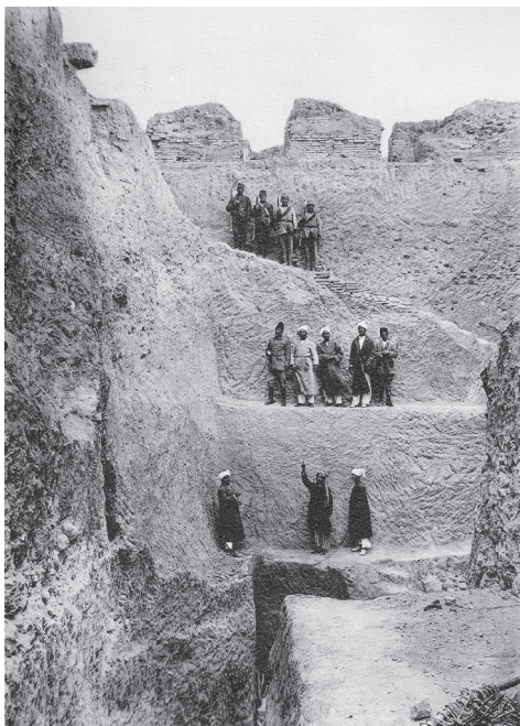
Figura 2 : La gran trinchera de Balkh excavada por A. Foucher (©DAFA)
