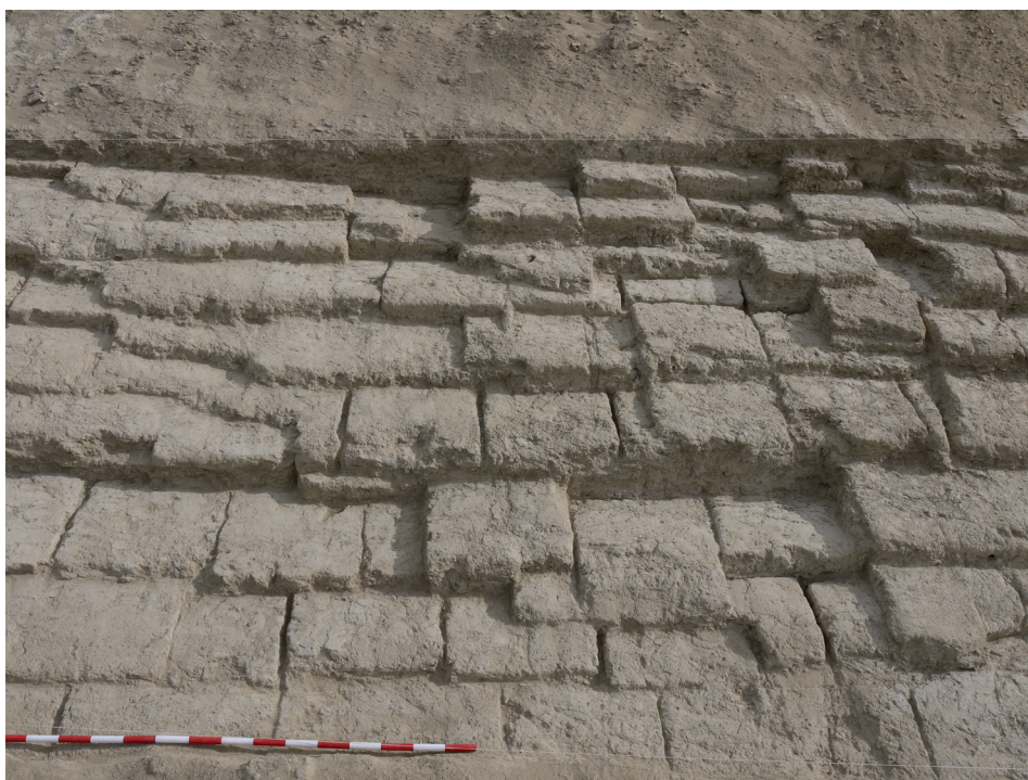
Abb. 11.- Mauerwerk auf der Südseite von Geoktchik (Photo: Spanische und Turkmenische Mission).
