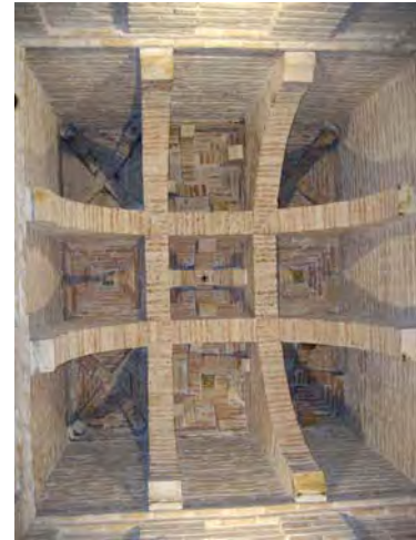
Fig. 4. Bóveda del tramo central de la mezquita de las Tornerías
