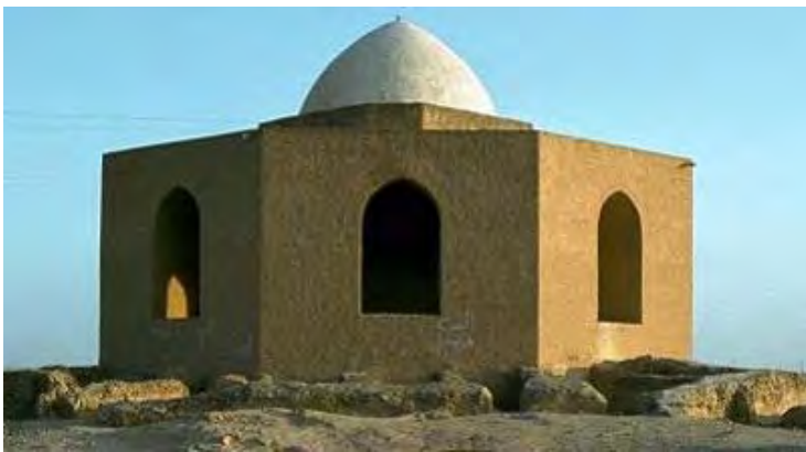
Fig. 17. Qubbanta al-Sulaibiyya, Samarra
