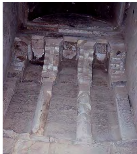
Fig. 26: Modillones de rolo en el pasadizo que conecta la mezquita de Ibn Tulun con su alminar
