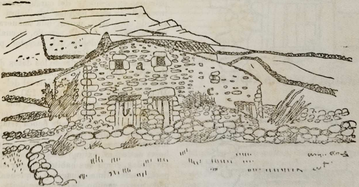
Fuentetoba: Taina o majada dentro del pueblo, con vivienda adosada. a. Piso superior: «yerbero». b. Piso inferior: «majada». c. Vivienda adosada. d. Cobertizo para el cerdo. Profusión de cercados en los campos. (Véase la típica chimenea cónica para leña).
