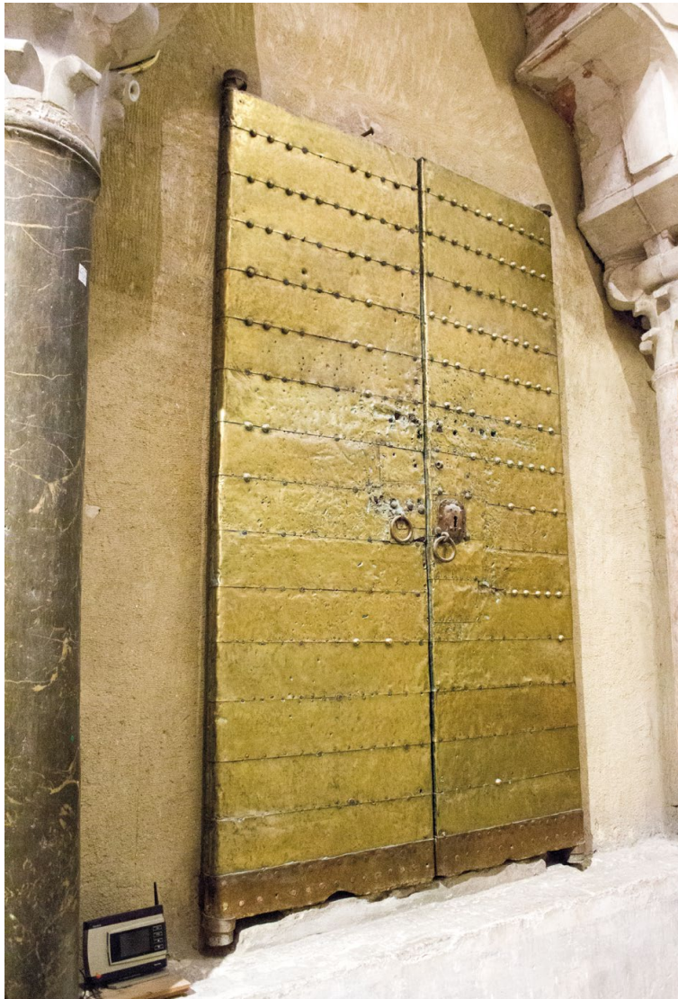
Figura 6. Puerta califal de madera recubierta de bandas de aleación de cobre en la Mezquita de Córdoba. Autoría propia
