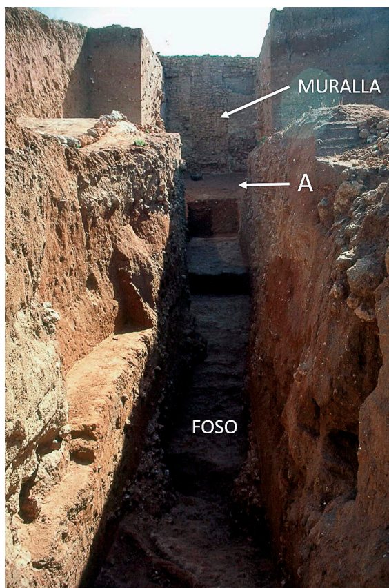
Figura 21. Vista de la muralla fenicia del siglo VIII que ceñía la ciudad. Se señalan los 4,5 m de muralla fenicia del VIII conservada, el basamento y el foso defensivo. No se advierte otro más adelantado
