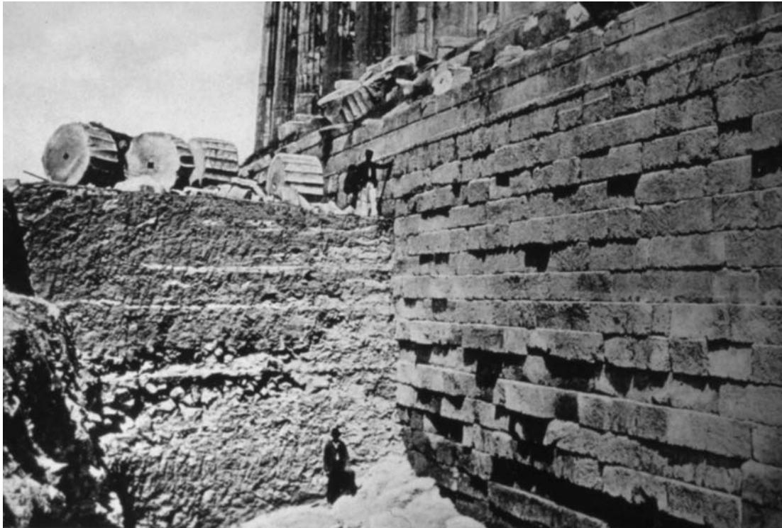
Lámina 8: Vista de los trabajos emprendidos por el arqueólogo Cavvadias en la acrópolis de Atenas, durante los que descubrió un importante conjunto de 15 korai. En Die Ausgrabung der Akropolis vom Jahre 1885 bis zum Jahre 1890, Lámina L.
