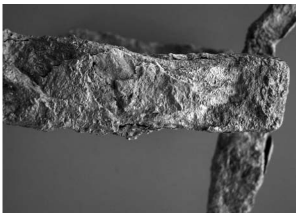
Figura 13. Hojaldrado, descamado y fuertes desprendimientos de las capas externas del morillo.
