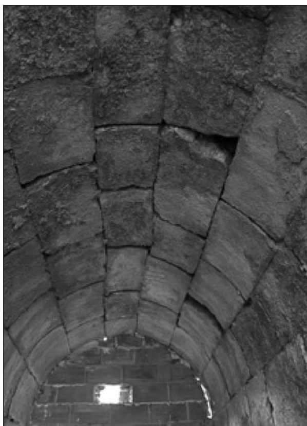
Figura 13. Detalle de la bóveda del cárcavo sur
