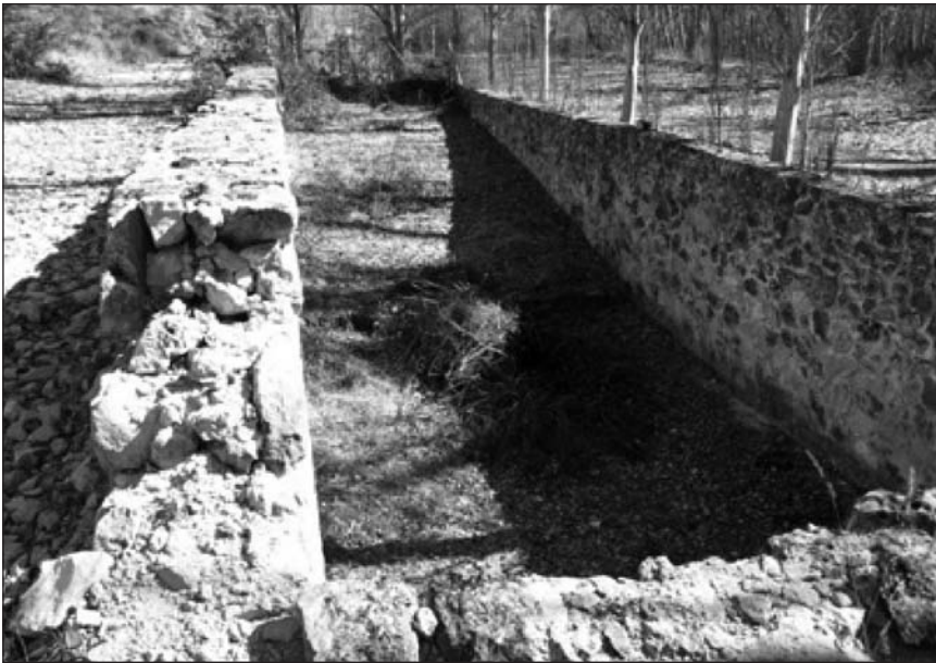
Figura 2. Vista del caz aguas arriba
