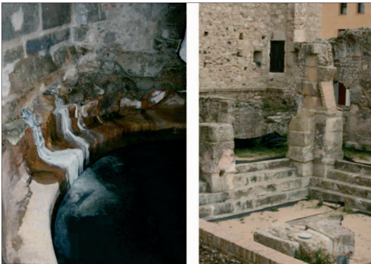
Figura 3b. Imágenes de los balnearios de descritos: Interior de la sala principal del balneario romano de Caldes de Montbui; vista general del balneario romano de Fortuna con la grieta de la surgencia en el fondo. Fotos autora.
