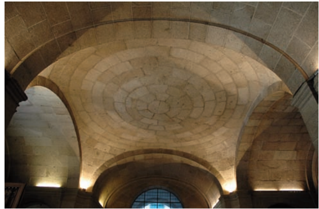
Fig. 20. Monasterio de San Lorenzo de El Escorial, bóveda del sotacoro de la iglesia (Javier Ibáñez Fernández).
