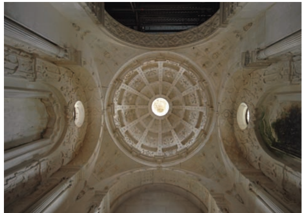
Fig. 19. Convento de San Marcos de Coímbra, capilla de los Reyes Magos (Javier Ibáñez Fernández).
