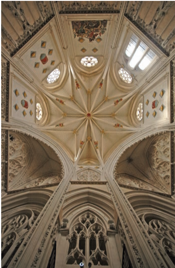
Fig. 2. Toledo, catedral, capilla de Santiago, sistema de abovedamiento (Javier Ibáñez Fernández).
