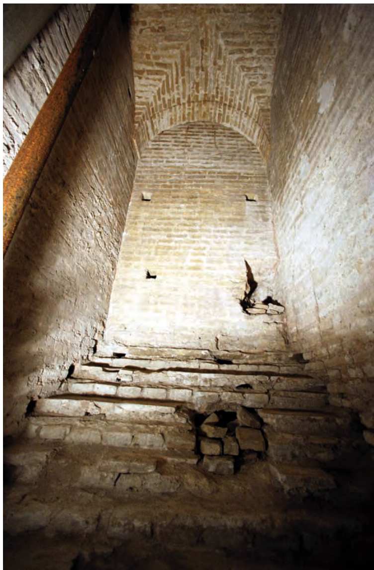
Fig. 7. Arranque de la escalera fallida (A. Almagro).
