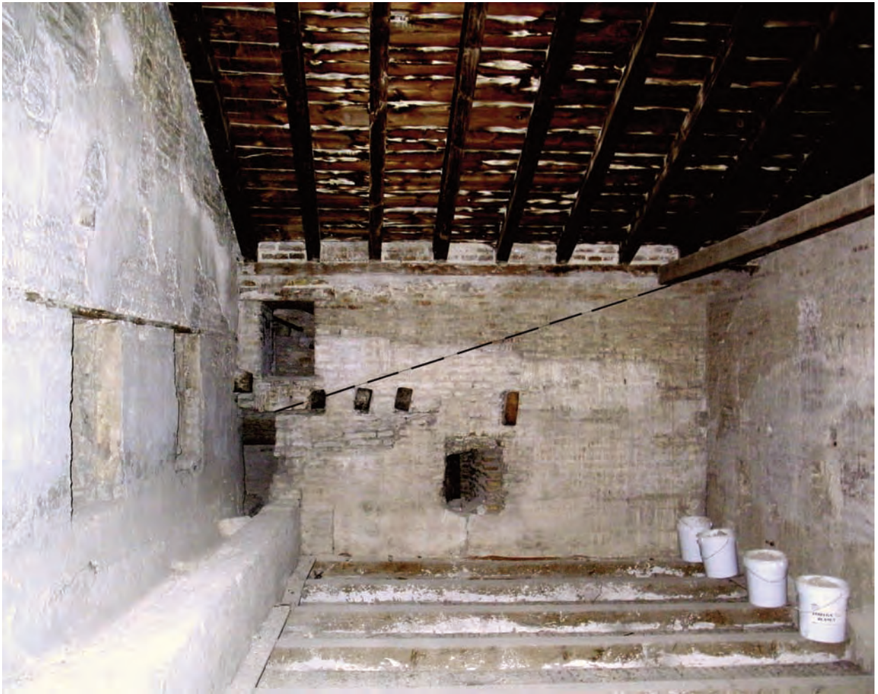
Fig. 15. Espacio correspondiente al camaranchón sobre la alhanía oriental de la qubba del piso alto (A. Almagro). Pueden verse a la izquierda las ventanas de la qubba y el canal de recogida de aguas del tejado de la alhanía. En línea de trazos se ha dibujado la forma de este último. En el muro del fondo se aprecian las testas de las vigas que forman los canes del alero de la portada del palacio.
