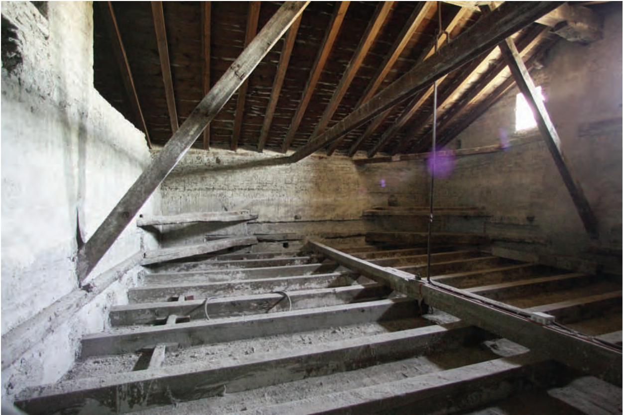
Fig. 16. Camaranchón correspondiente al vestíbulo de la planta alta del palacio de Pedro I (A. Almagro). Pueden verse los estribos y cuadrales de la primitiva armadura ochavada que cubría dicha sala.
