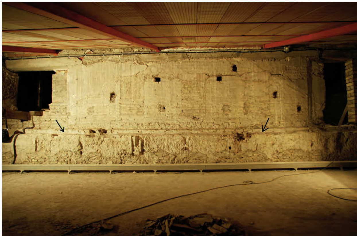
Fig. 11. Huella del estribo de la armadura de la sala alargada del piso alto. Se aprecian las tres ventanas cegadas del lado sur de la qubba y la huella del tejado (A. Almagro).
