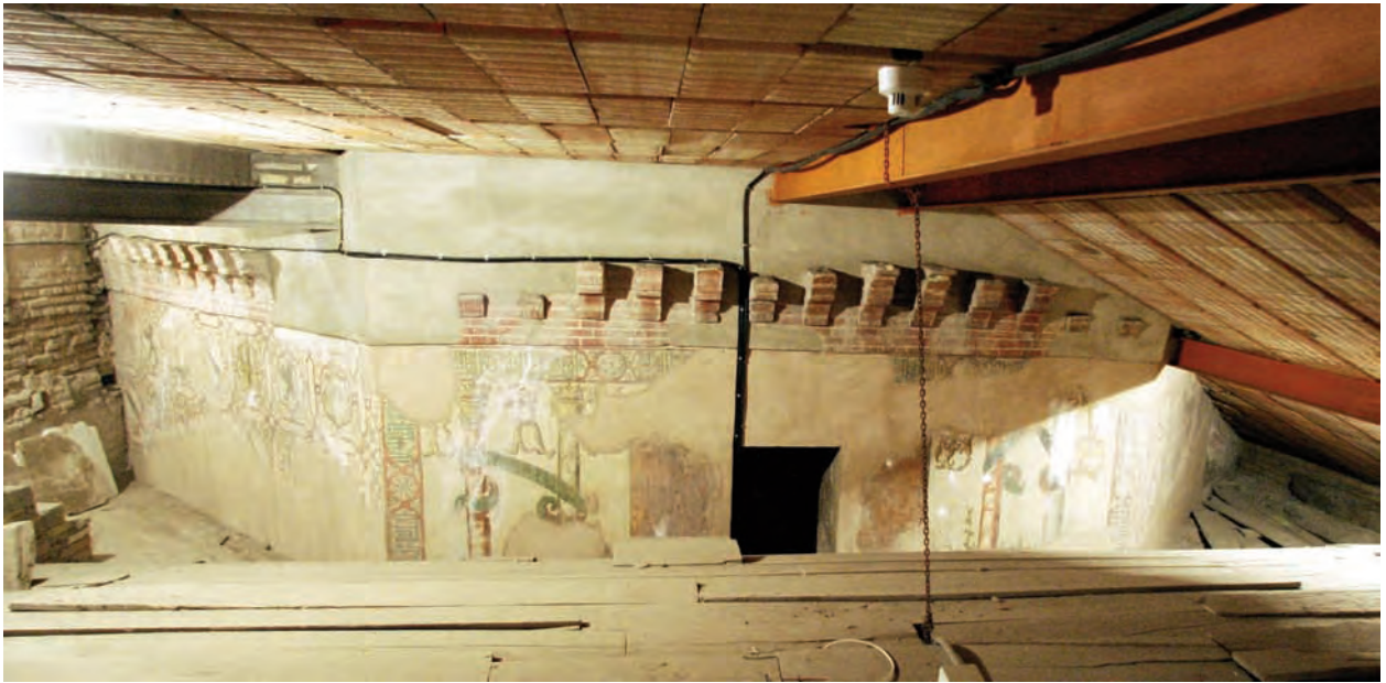
Fig. 26. Lado sur de la qubba de la Media Naranja con los modillones de su cornisa y la decoración del siglo XVI conservados bajo la cubierta actual (A. Almagro).
