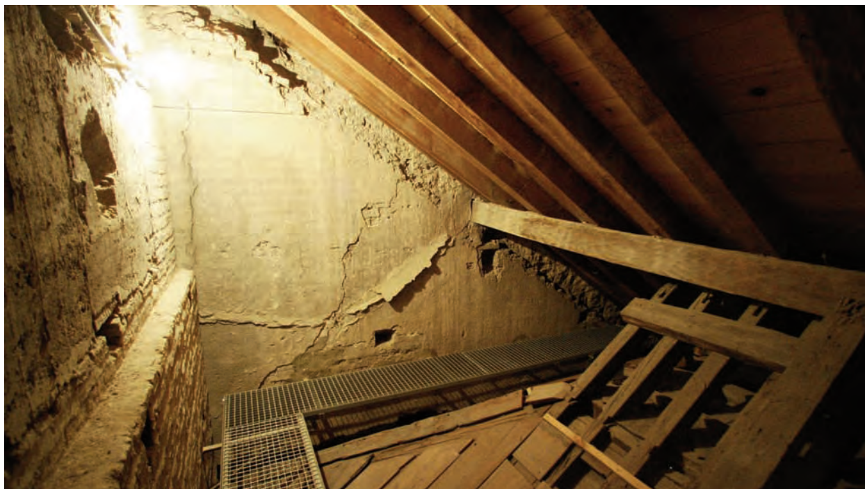
Fig. 29. Camaranchón sobre la sala de la reina Isabel, actual vestíbulo del piso alto (A. Almagro). Arriba a la izquierda puede verse un fragmento de la cornisa original de la obra de tiempos de Pedro I con su enlucido. En el centro se ve la huella del tejado inicial del añadido de tiempos de los Reyes Católicos. Abajo se aprecia la roza abierta en el muro primitivo para apoyo de la armadura. El muro de la izquierda corresponde a una reforma de las cubiertas de fecha desconocida, cuando se modificó el tejado haciéndolo a un solo agua.
