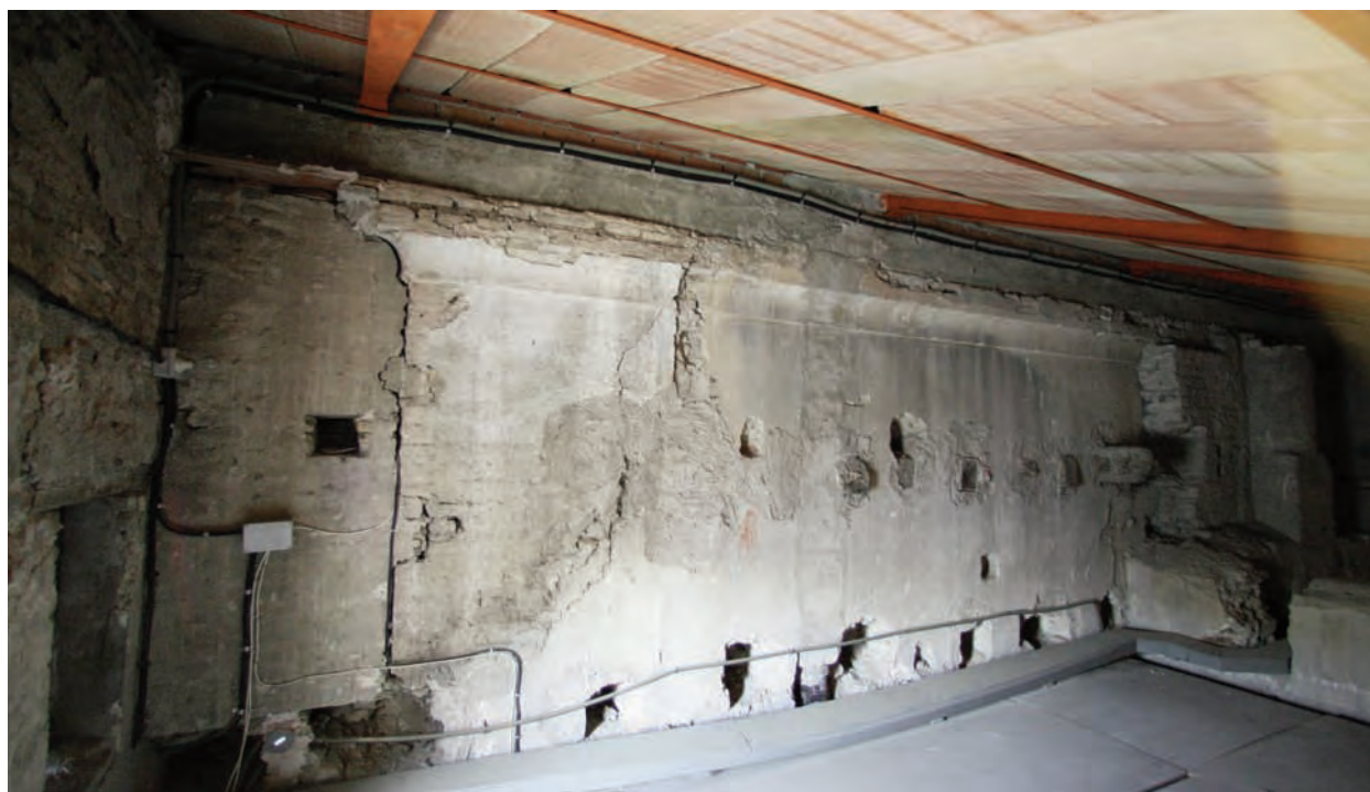
Fig. 30. Lado sur del ala occidental del piso alto de tiempos de Pedro I con su cornisa original incluyendo su solución del ángulo (A. Almagro).
