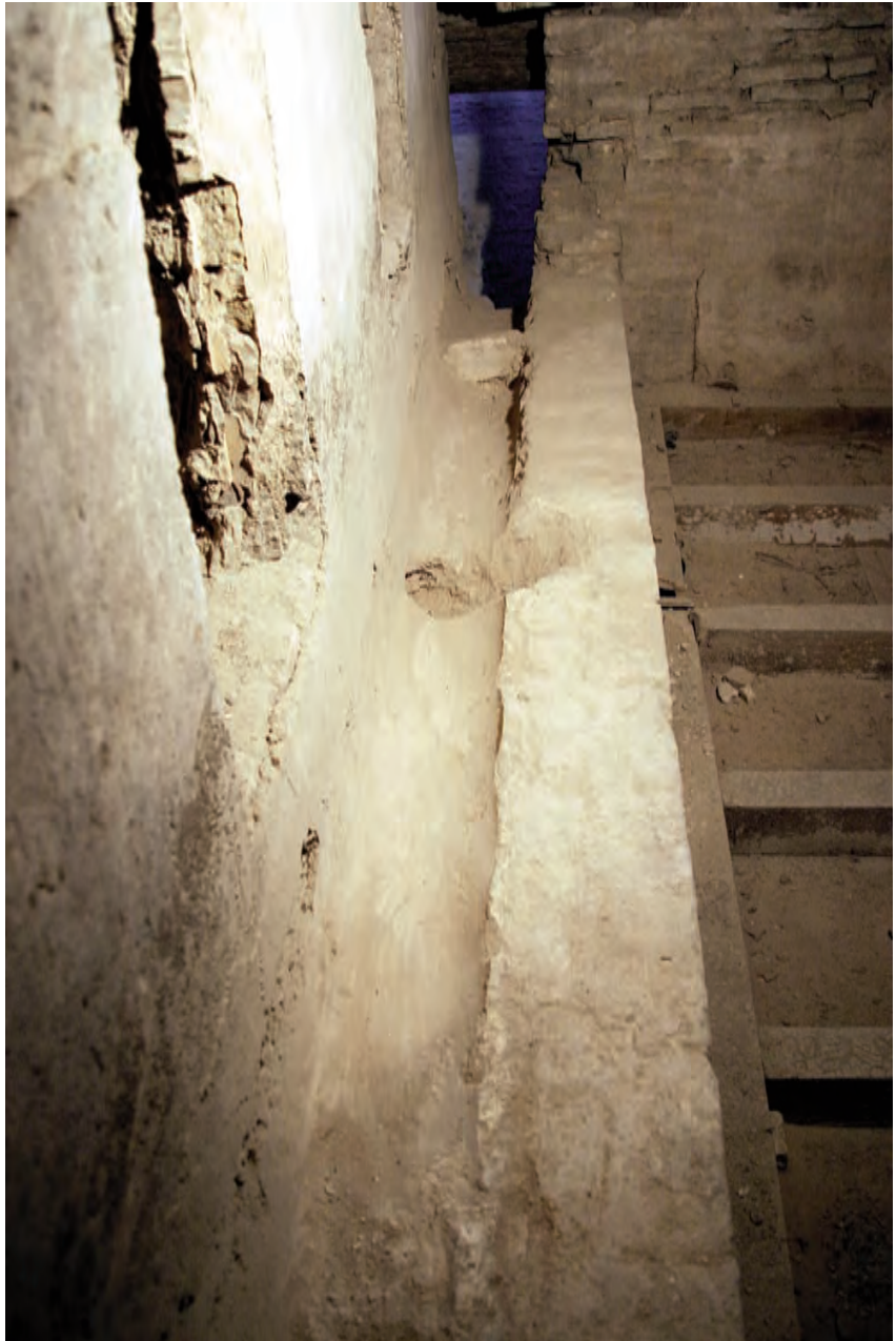
Fig. 31. Canal de desagüe adosado al lado oriental de la qubba del piso alto. Puede verse una de las ventanas de ésta con restos de la celosía (A. Almagro).
