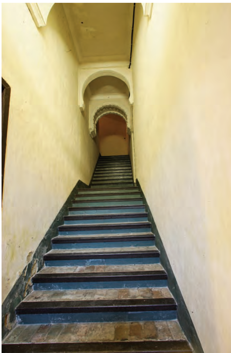
Fig. 6. Primero y segundo tramos de la escalera privada (A. Almagro).
