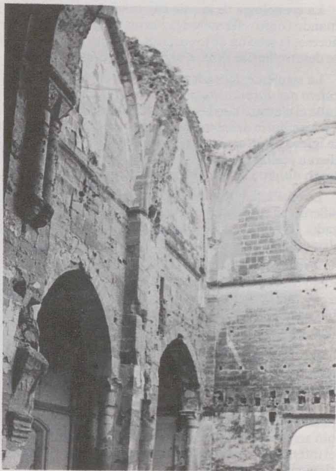
Fig. 16. Nave central hacia los pies.
