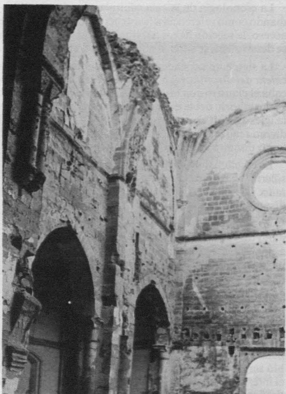
Fig. 16. Nave central hacia los pies.
