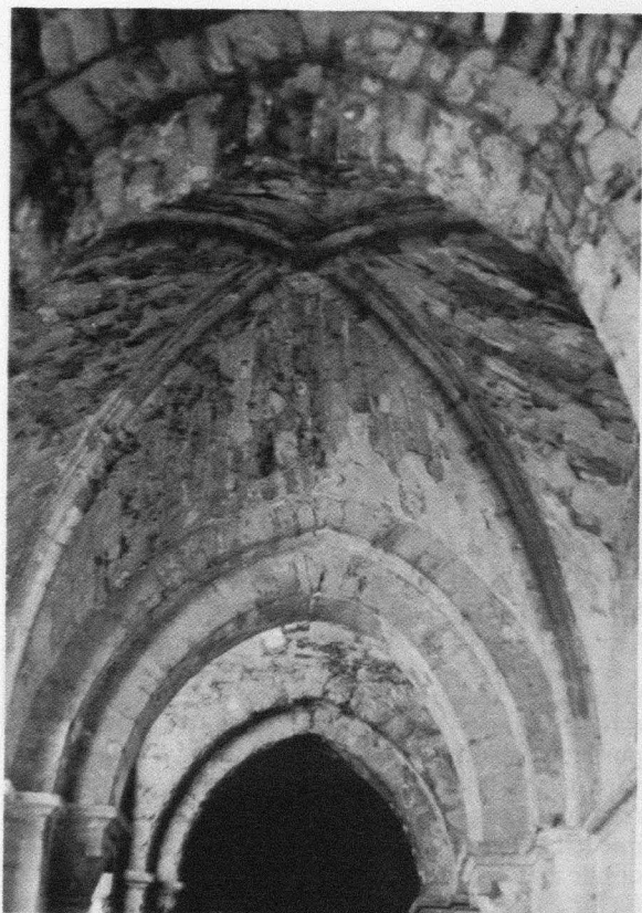
Fig. 13. a. Nave meridional; b. Crucero.
