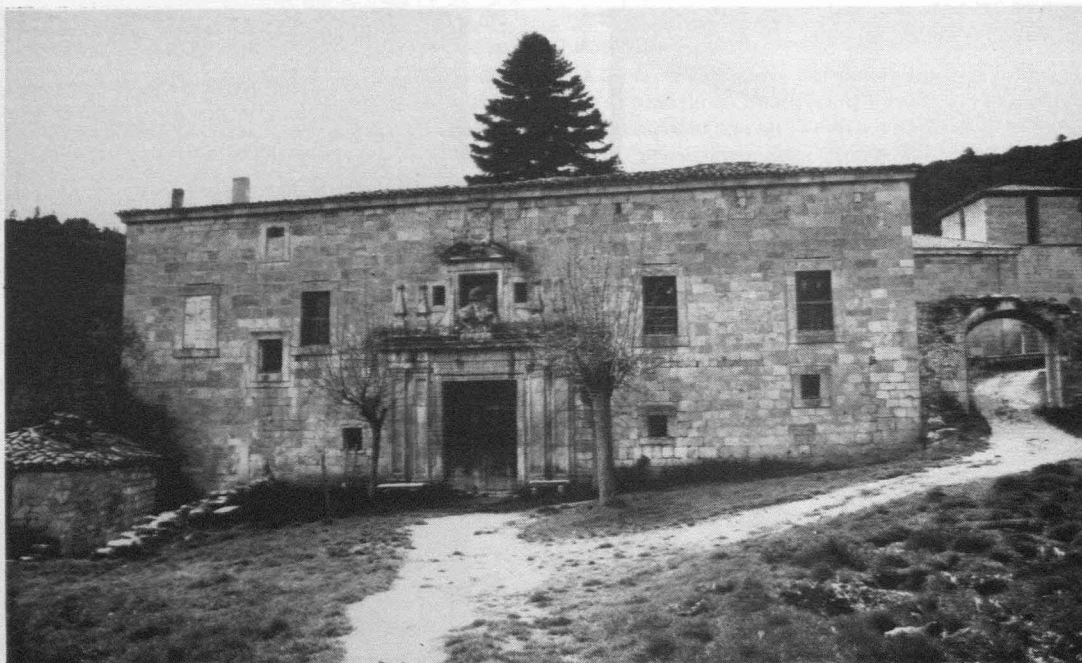
Fig. 8.—Fachada principal del monasterio.
