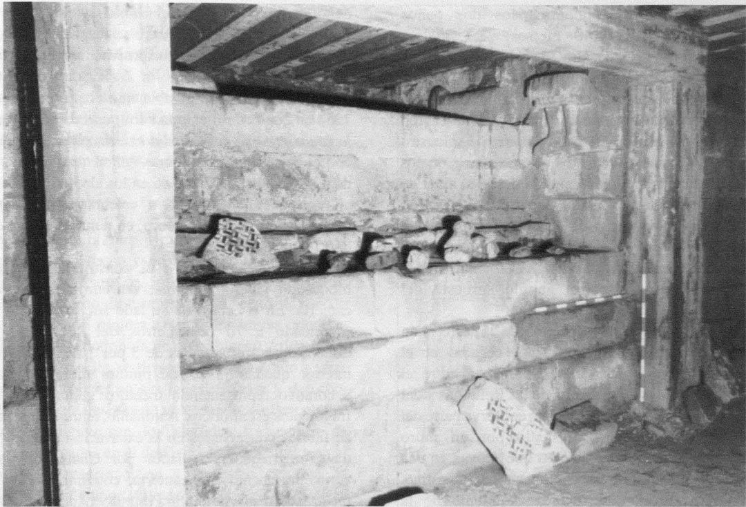
Fig. 5. Piso bajo de la torre de don Gómez Manrique.
