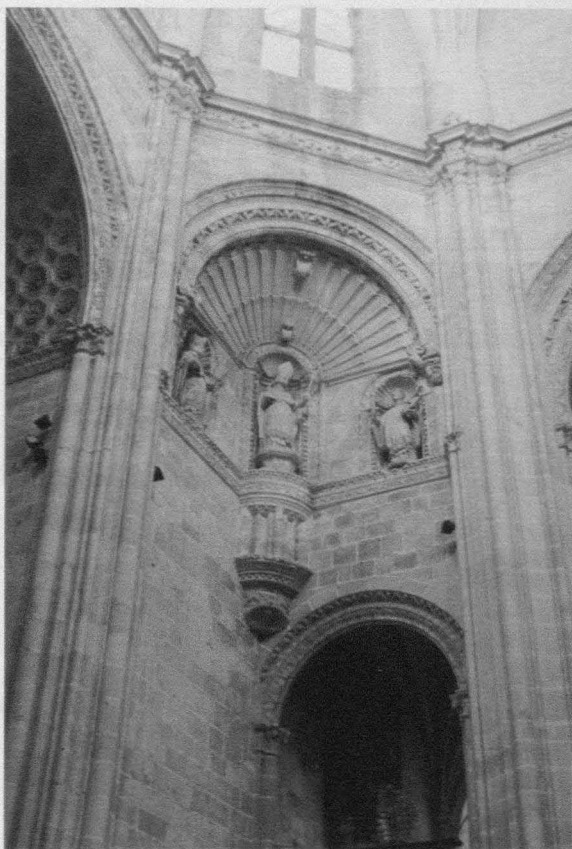
Fig. 5. Detalle del interior de la capilla funeraria de La Vid
