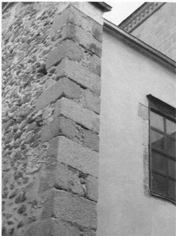
Fig. 4. Vista exterior de la capilla y del contrafuerte.
