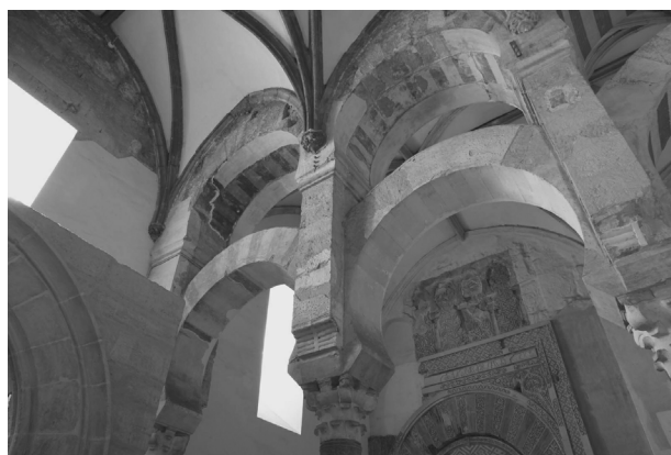
Fig. 7. Dovelas de ladrillo fingido en la ampliación de la gran mezquita de Córdoba en tiempos de Almanzor
