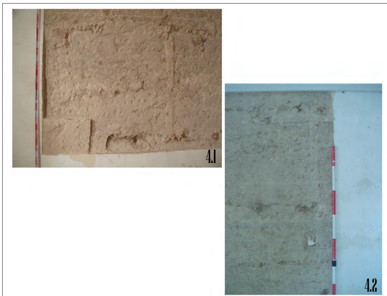
Fotografía 4. Fase Almohade III. Detalles del enlucido almohade. Muro de unión ente la Torre de la Atalaya y la Alcazaba (4.1) y flanco sudeste de la Torre de la Atalaya (4.2), actual edificio de La Galera.
