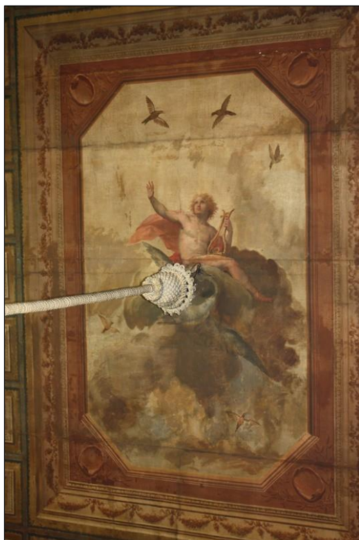
Fig. 2- Techo del Salón de Apolo en el Cuartel General de la Armada. Madrid. Foto de la autora.
