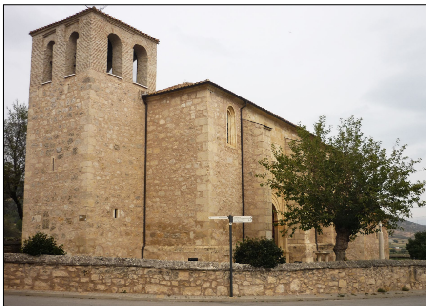
Fig. 1- Vista general de la iglesia de San Pedro Advíncula, Redueña. Fotografía de la autora.
