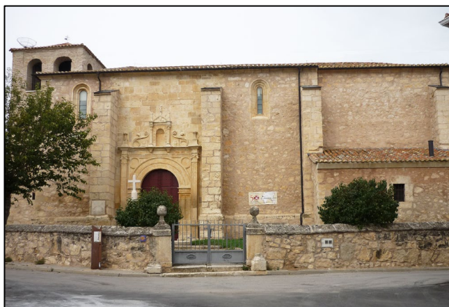
Fig. 23- Vista general desde el sur. Sacristía a la derecha de la imagen. Fotografía de la autora
