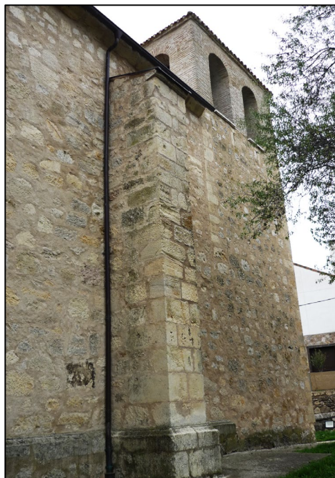
Fig. 4- Detalle de muros de torre y nave. Fotografía de la autora.
