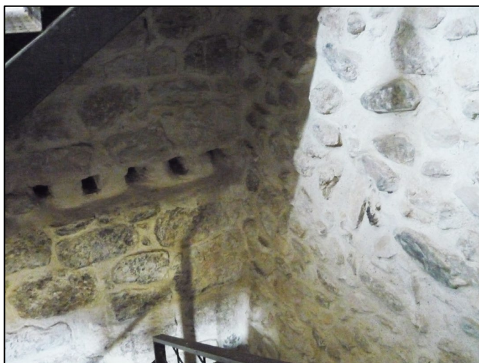
Fig. 5- Marcas de vigas en el interior de la torre. Fotografía de la autora.
