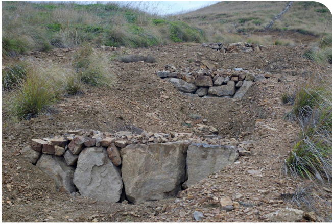
Figura 3. Muros tradicionales para retención del suelo ("encadenats") construidos en una de las poblaciones de Femenisia balearica para reducir los procesos erosivos.
