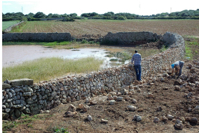
Figura 2. Restauración de muros tradicionales de piedra en seco como protección a un estanque temporal mediterráneo. Foto LIFE BASSES.
