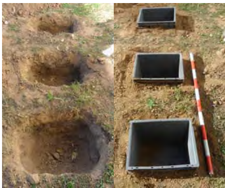
Figura 5. La fase de excavación y posterior colocación de las cajas.
