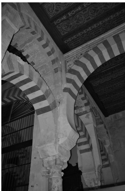
Figs. 15 y 16. Detalle de la inserción de uno de los arcos sobre los ya existentes.
