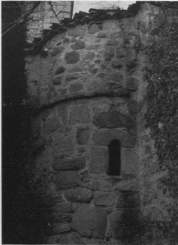
Lám. 1. Exterior del ábside meridional.
