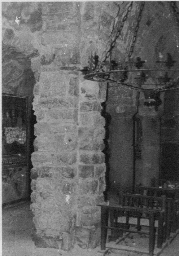
Lám. 8. Pilar delantero y columnas de separación de naves.
