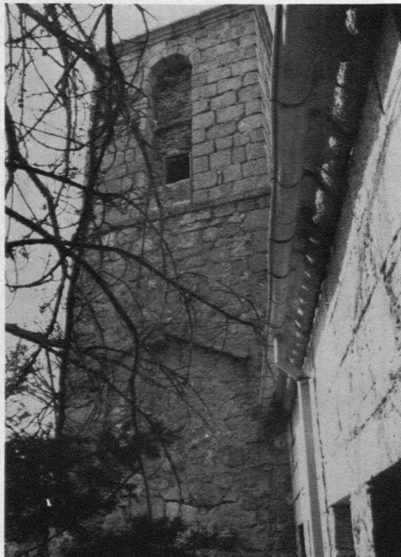
Lám. 13. Torre, lado norte.
