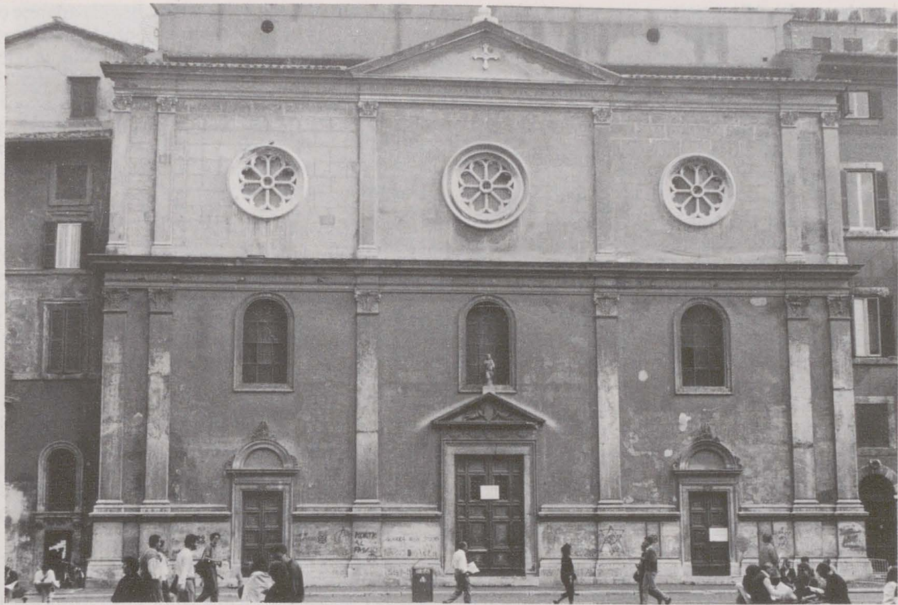
Fig. 1. Iglesia de Santiago de los Españoles. Roma. Fachada a Plaza Navona. c. 1500 con reformas en el siglo XIX.
