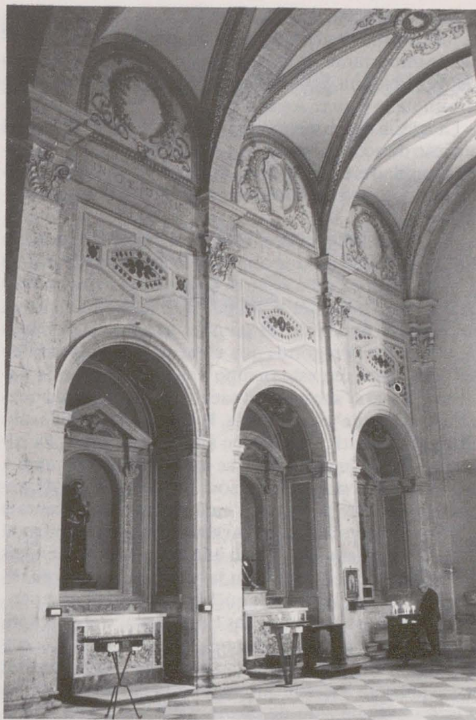
Fig. 7. Cabecera. Nave del Evangelio.
