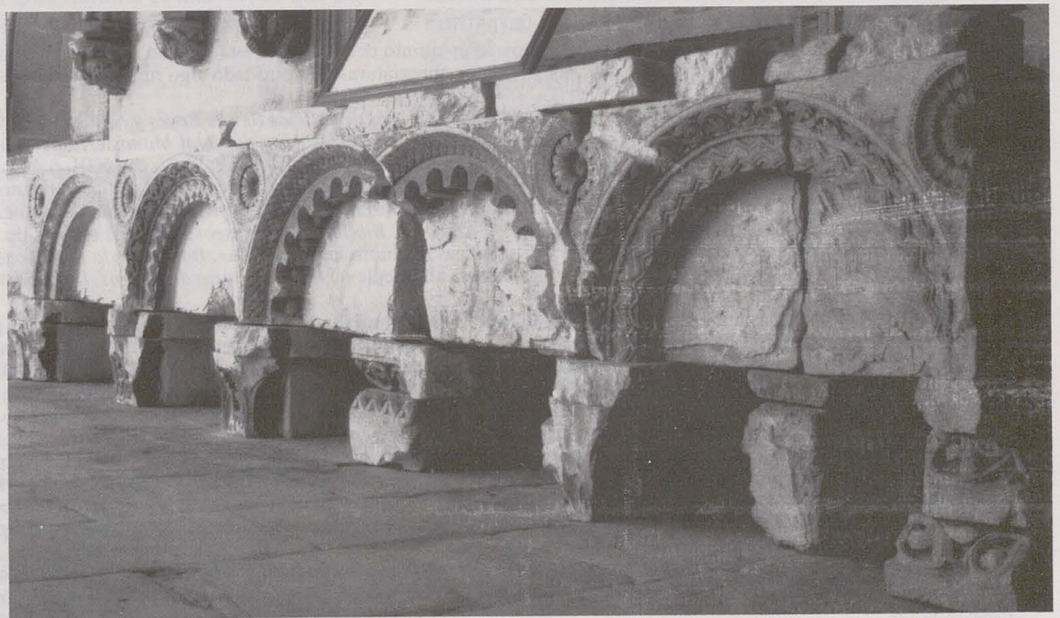
Fig. 2. Oña. Frontal del refectorio. Estado actual en la panda norte del claustro.
