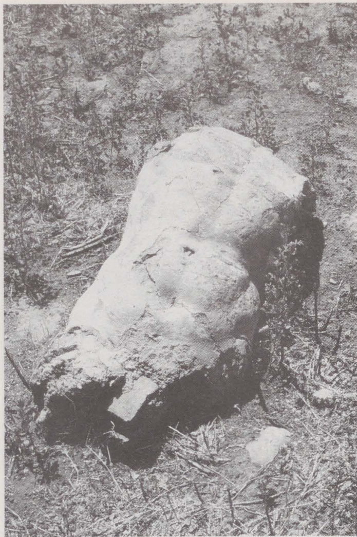
Fig. 14.—Fragmento escultórico desprendido de la Capilla de Plutón (Fot. P.).
