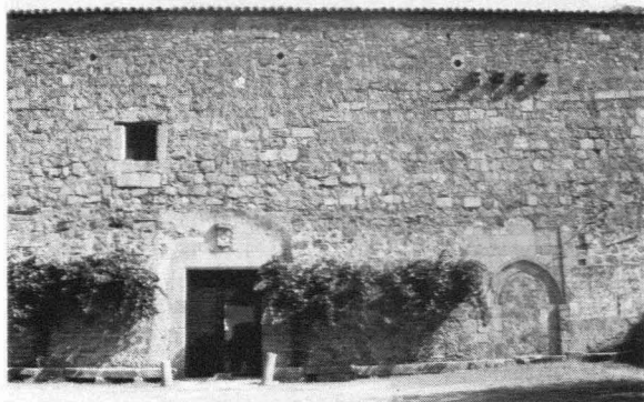
Fig. 2.—Abadía. Fachada principal del palacio (Fot. J.L. Gutiérrez).
