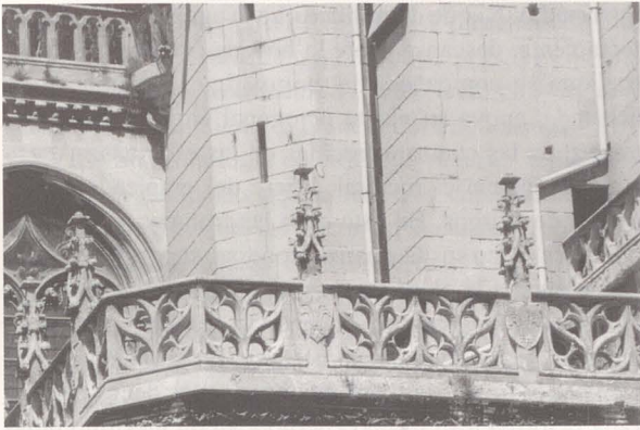
Fig. 15. Antepecho de la capilla de la Visitación, catedral de Burgos.
