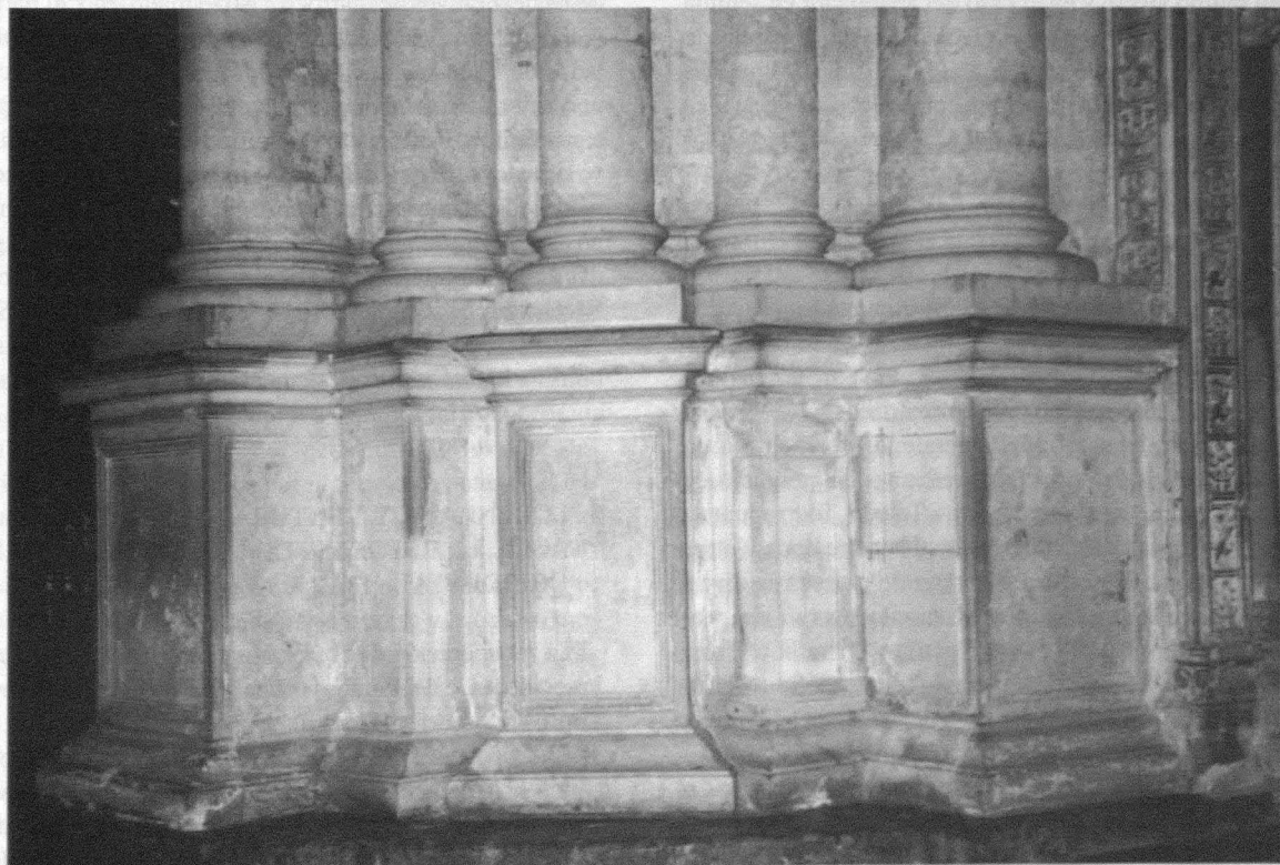
Fig. 5. Catedral de Toledo, basas del pilar del coro que mira a la capilla mayor (1774-1775).
