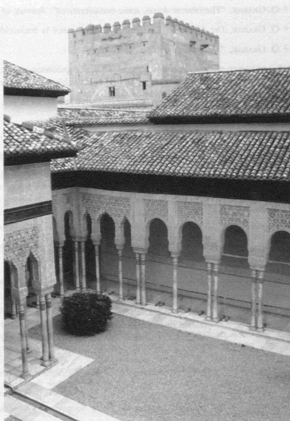
Fig. 13. Ángulo N-W del Patio de los Leones.
