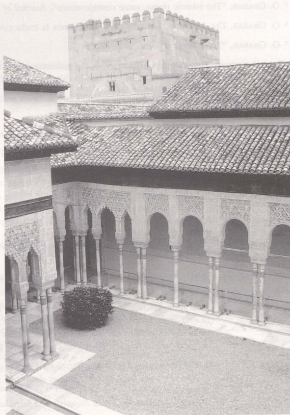
Fig. 13. Ángulo N-W del Patio de los Leones.
