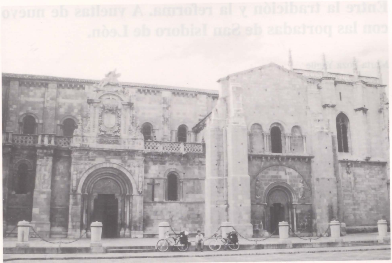
Fig. 1. Posición de las portadas en el muro meridional.
