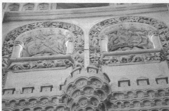
Fig. 4. Detalle de dos arcos de la galería superior.
