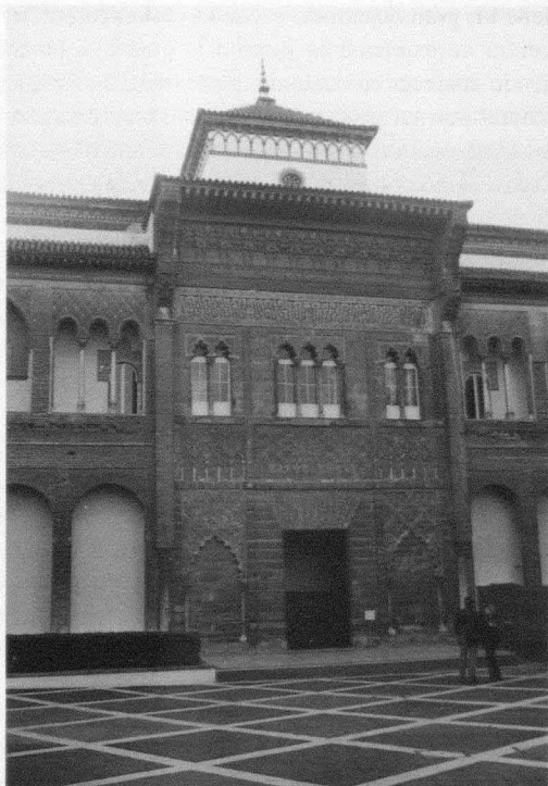
Fig. 9. Fachada de la Montería. Alcázar de Sevilla, 1364.
