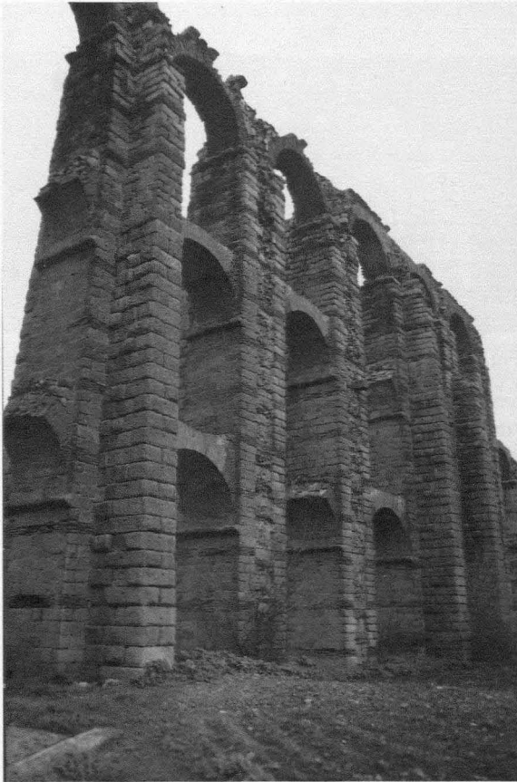
Fig. 2. Acueducto de los Milagros (Mérida), ss.I-II.
