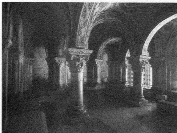
Fig. 3. Vista del interior del Panteón. León.
