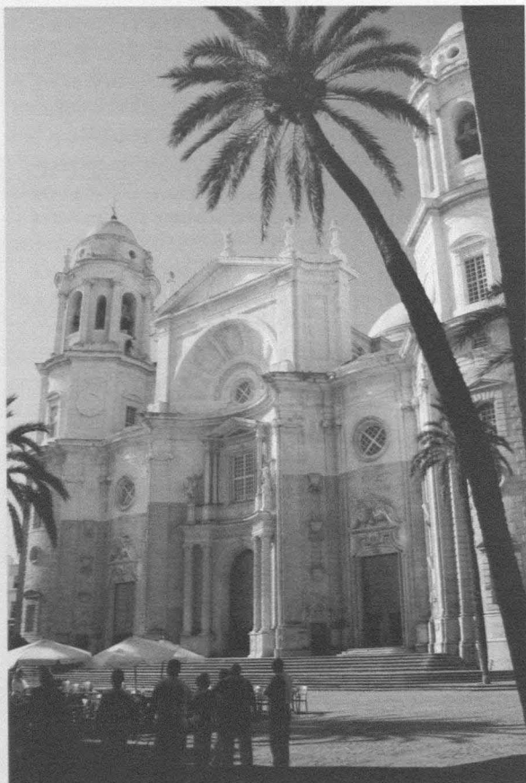
Fig. 16. Catedral de Cádiz. Fachada (Foto F. Marías).
