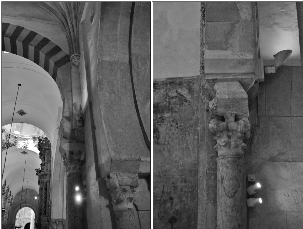
Figs. 19 y 20. Detalles de la columna sobre la que descansa el arco oriental.
